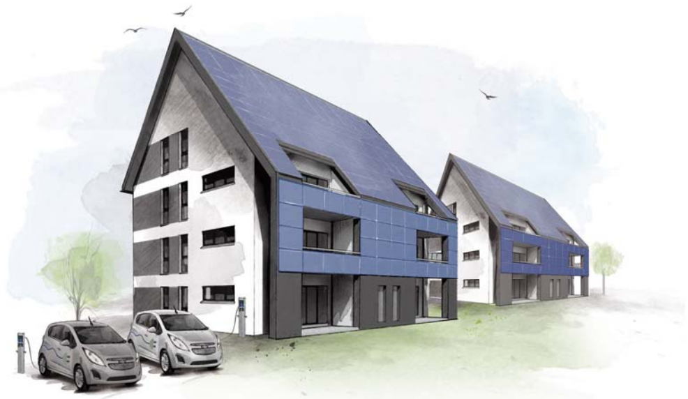
➤ Abb.: Miete mit Energieflat: Zwei energieautarke Mehrfamilienhäuser mit je 7 Wohneinheiten in Cottbus, Baubeginn 2017. 100 m 2 Solarthermie mit 25 m 3 Langzeitwärmespeicher sowie 30 KWP Photovoltaik auf dem Dach und an den Balkonen mit 54 kWh Akku erreichen zwischen 65 und 77 solare Deckung bei Strom und Wärme. Der Vermieter kann dem Mieter für mehrere Jahre eine Pauschalmiete anbieten, in der Wohnen, Wärme, Strom und E-Mobilität als Flatrate bereits enthalten ist.
