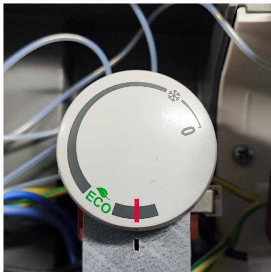
Abbildung 10: Thermostateinstellung des Überschussheizstabes R1 am Thermostat T1 bei 75 °C
