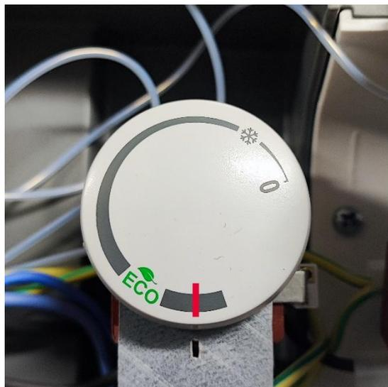
Abbildung 11: Thermostateinstellung des Überschussheizstabes R1 am Thermostat T1 bei 75 °C
